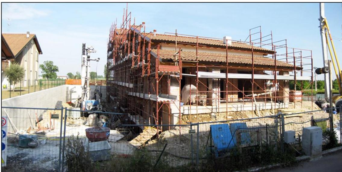
**Figura 12** – Esempio di cantiere con perforazione di sonde geotermiche verticali.
